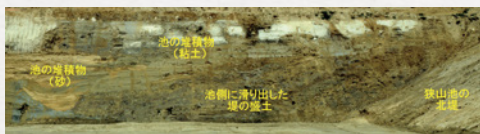
池の堆積物に舌状に滑り出した堤の盛土(1993年三田村撮影)
