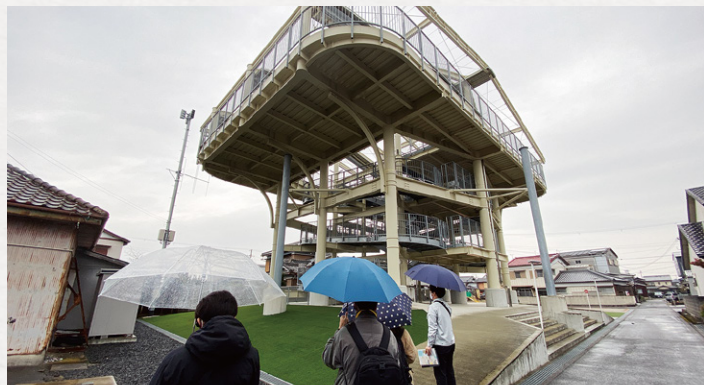
(御坊) 名屋地区津波避難タワー
