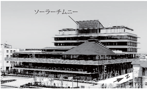
写真-1 実測対象建物外観
