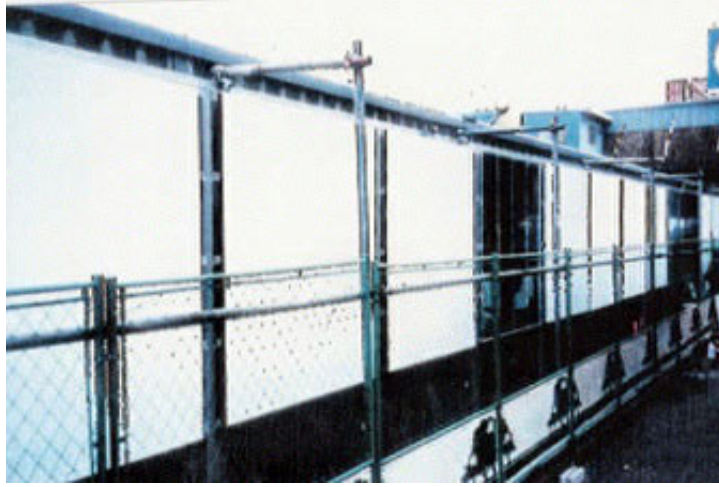
写真1：酸化チタン光触媒パネルによる窒素酸化物削減のための野外実験風景
