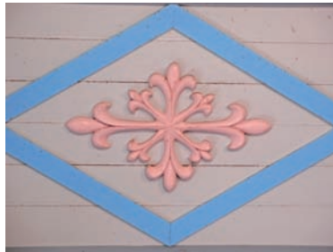
15 頭ヶ島教会堂 板張り天井 1919年 百合十字を二つ組み合わせたもの
